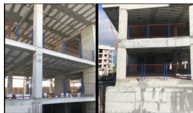
Figure 9. Proper edge protection
